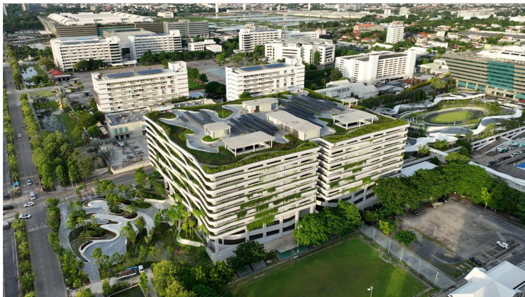
ภาพอาคารจอดรถของอาคารราชบุรีดิเรกฤทธิ์ที่เสร็จสมบูรณ์
